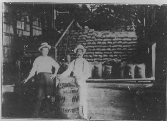
EL CENTRAL "LA VEGA".—Interior de uno de los almacenes de azúcar.
