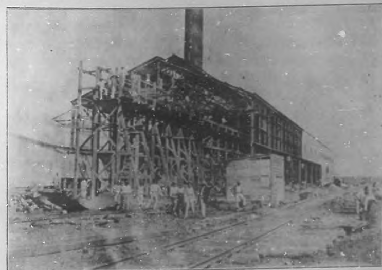
EL CENTRAL "ALGODONES".—La casa de máquinas en reconstrucción.
